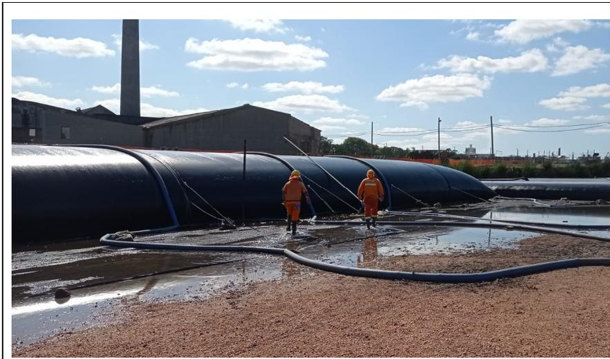
Proceso de llenado de geotextiles.
